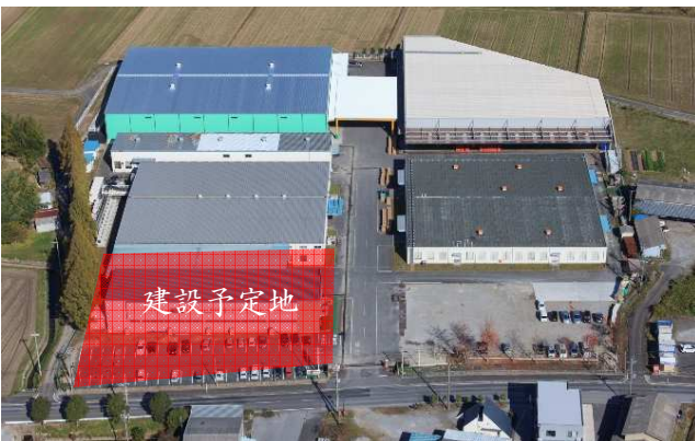
旧管理棟を解体して第13倉庫を建設
